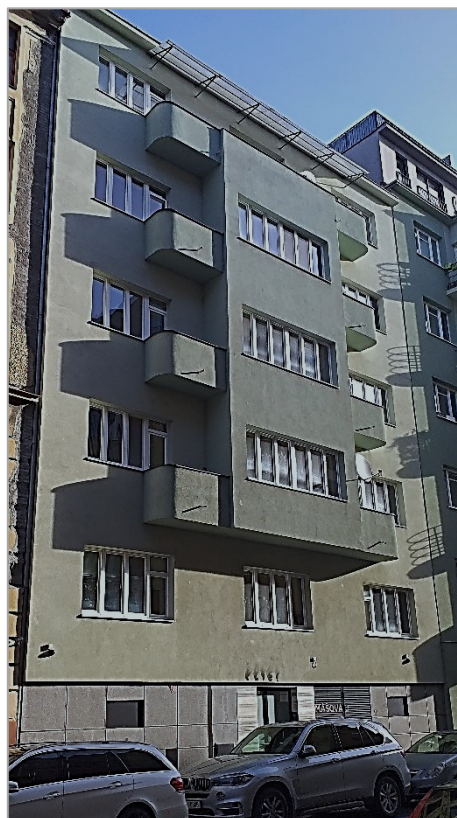
Před čištěním (foto 1/2023)
